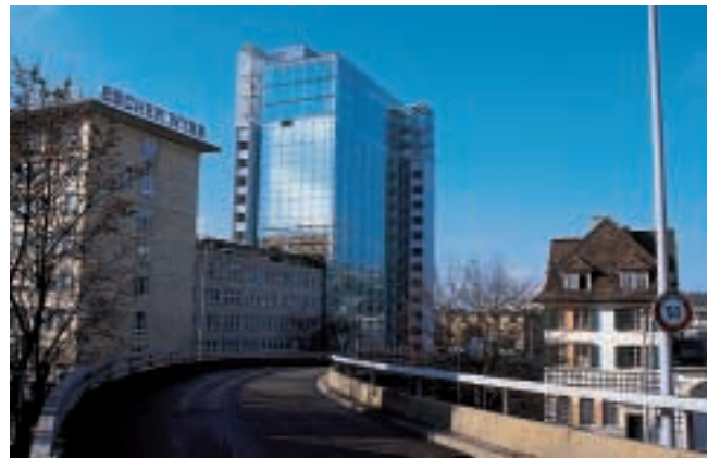
Abb. 1: Mobimo-Hochhaus: umstrittene Umgestaltung des ehemaligen Sulzer-Hochhauses.
